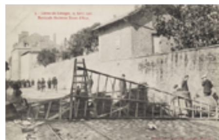
Grèves de Limoges, 1905 Barricades ancienne route d'Aix
